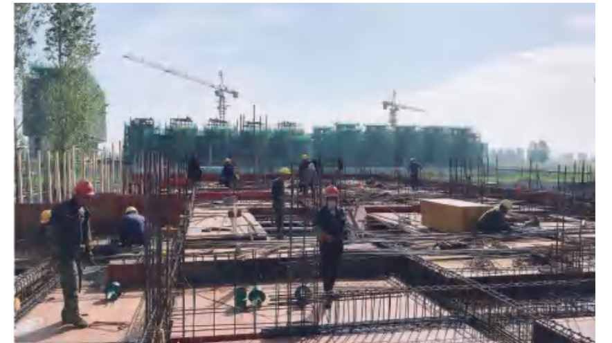
郑州中州院子工地
