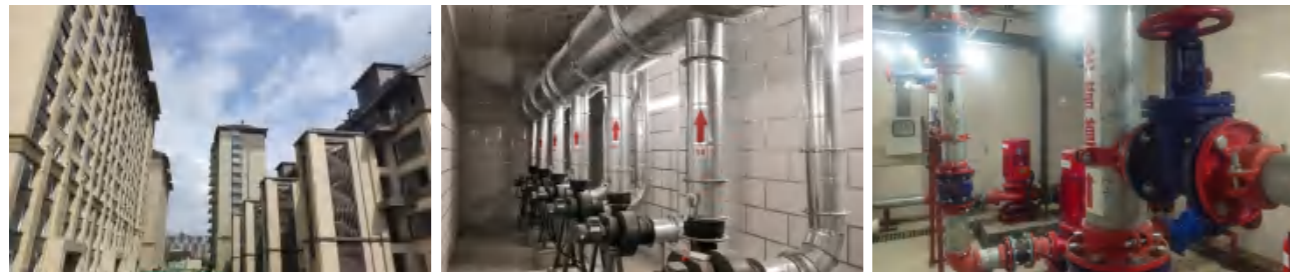
北京金府大院现场远景区
